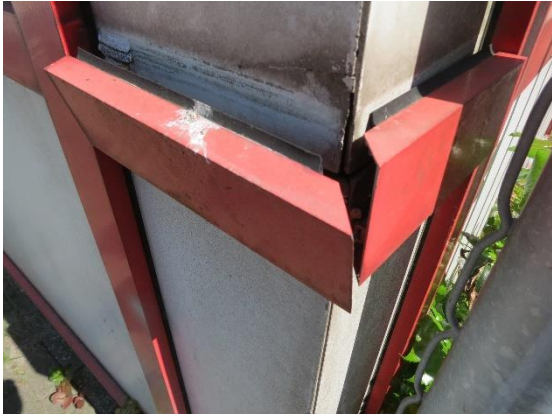
Afb.6. Loszittende profielen, rechter zijgevel.
