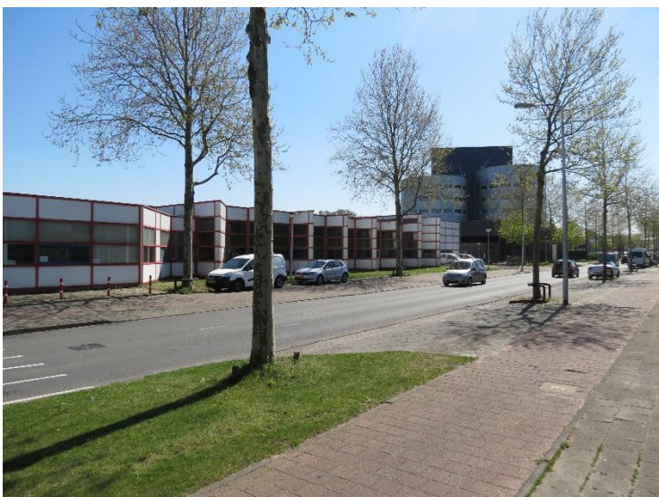
Afb.3. Voorgevel, rechter deel.
