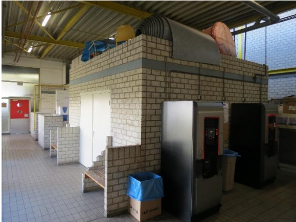
Afb.14-15. De sanitaire voorzieningen zijn ondergebracht in twee blokken. Let op het beschadigde muurtje van het linker blok, links van het bankje.
