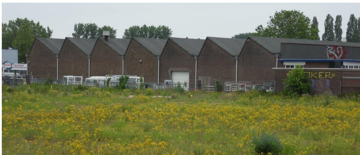
Afb.7. Achtergevel met rechts het transformatorhuis.
