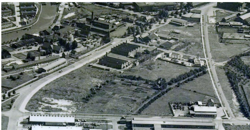
Isselt, met links de Nijverheidsweg-Noord en rechts de nieuwe Amsterdamseweg in aanleg. In het midden zijn de drie sheddaken van Van der Meiden te zien. Luchtfoto, ca.1952 (detail).
