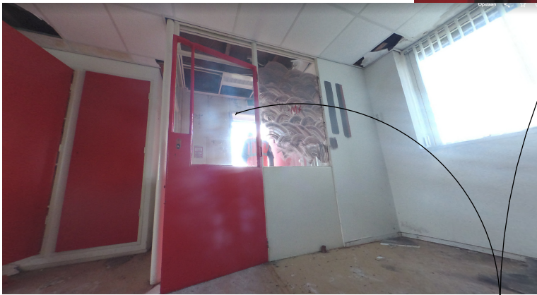
Stalenkozijn hergebruiken in nieuw ontwerp
