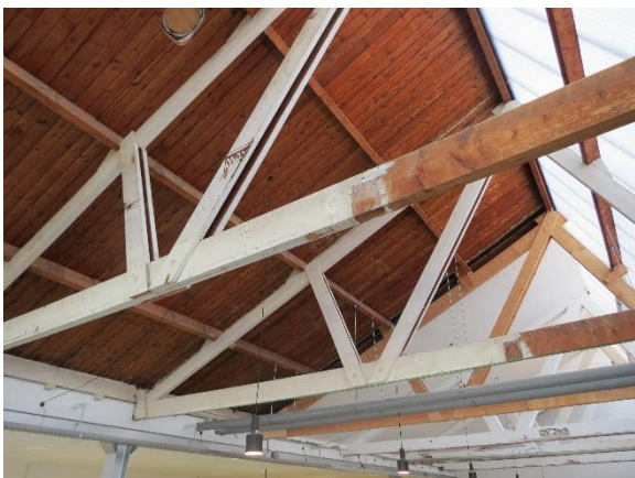
Afb.9. Houten constructie (detail).
