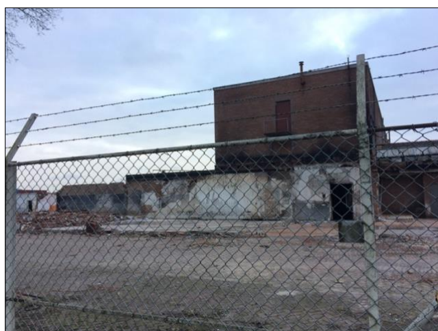
afb. 3: foto genomen vanaf de Soesterweg tijdens de sloopwerkzaamheden - 30 januari 2018
