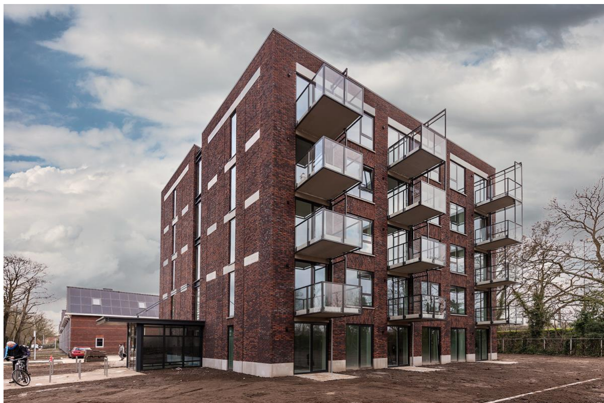
Afbeelding 10: Het appartementencomplex Soesterweg 568, met links het glazen entreegebouw waarin zich de latei en de historische foto bevinden – foto: Fred Oosterhuis
